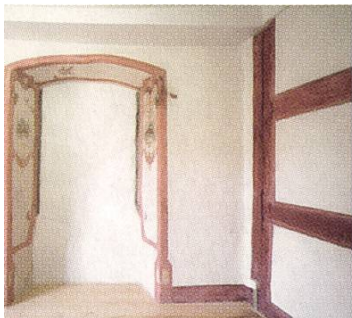
Zugemauertes Fenster 2. Stock, Südfassade, Renaissance-Malereien in den Laibungen; oben bei der Freilegung, unten restauriert.
