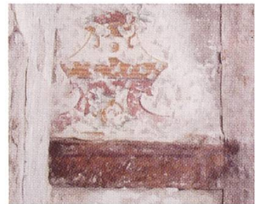
Renaissance-Motiv über zugemauertem Durchgang in der Westwand, Wohnraum, 2. Stock, sog. «Sopraporte», denkmalpflegerisch analysiert und gesichert, heute mit Gipsplatte überdeckt.
