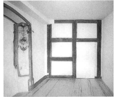
Das «Renaissance-Zimmer» im 2. Stock wird dominiert von der Malerei in der Fensternische sowie von den Riegeln in der Westwand und dem zugemauerten Durchgang.
