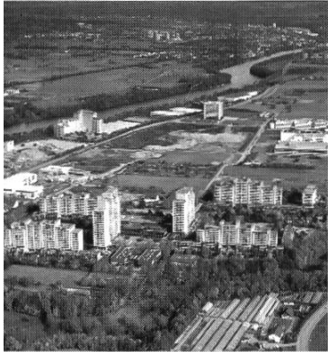
Die Liebrüti, eine von der Wohlfahrtsstiftung Roche erstellte Grossüberbauung mit gegen 900 Wohneinheiten, brachte der Gemeinde Kaiseraugst eine Verdreifachung der Einwohnerzahl. Siehe auch vorangehende Doppelseite
