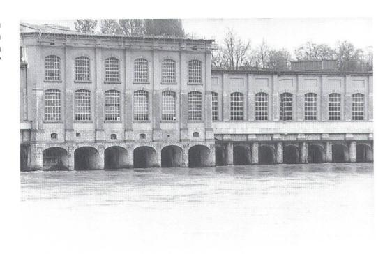
stalteten Mittelteil befand sich früher, auf einer Empore, die Schaltzentrale. Die zwischen die Fenster gestellten Pilaster demonstrieren auch am Aussenbau die Stärke, mit der im Innern die neuen Maschinen dem Fluss Energie abtrotzen. Die dem Schlossbau entliehenen Architekturelemente sind Symbol des Selbstverständnisses der Kraftwerkbetreiber, Herrschaftsausübung über die bisher ungezähmte Kraft des Wassers.
