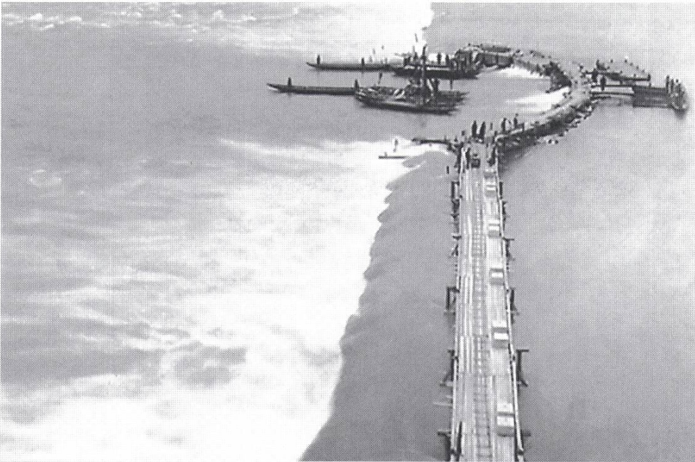
Bau des Stauwehrs von der Schweizer Seite aus, 1899
