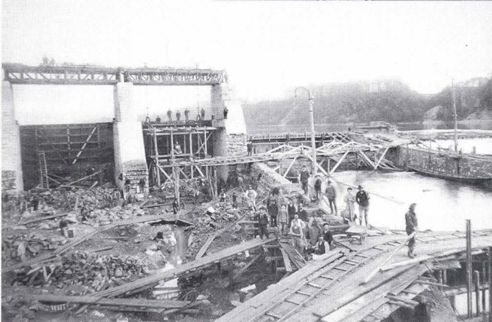
Bau des Stauwehrs mit Grundablässen (links) und Floss- gasse, 1899
