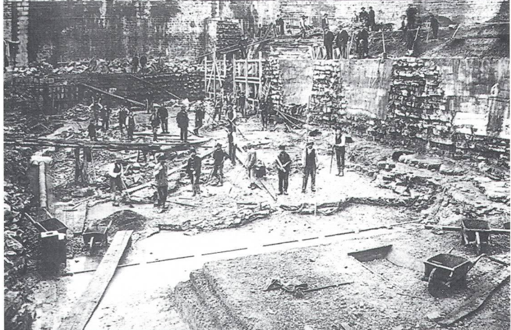
Arbeiter beim Bau der Fundamente und Mauern des Maschinenhauses, 1896
