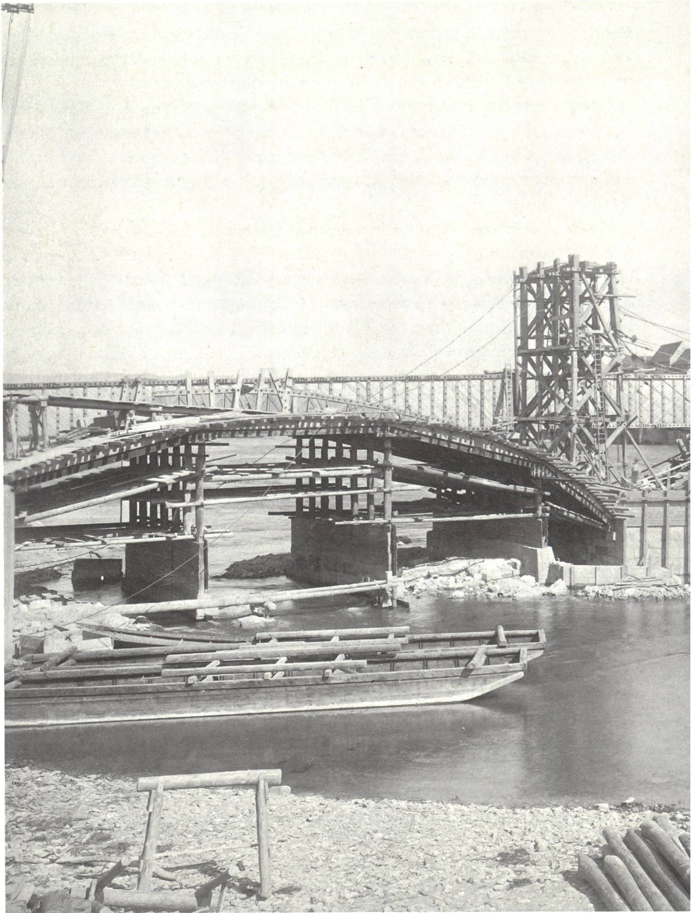
Abb. 20: Neubau der Brücke, Schalungsarbeiten.
