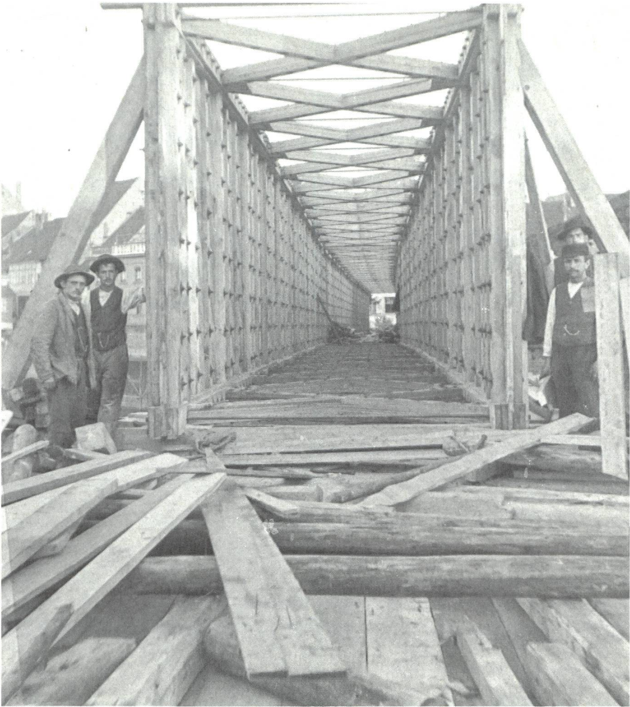
Abb. 16: Bau des Notsteges.
