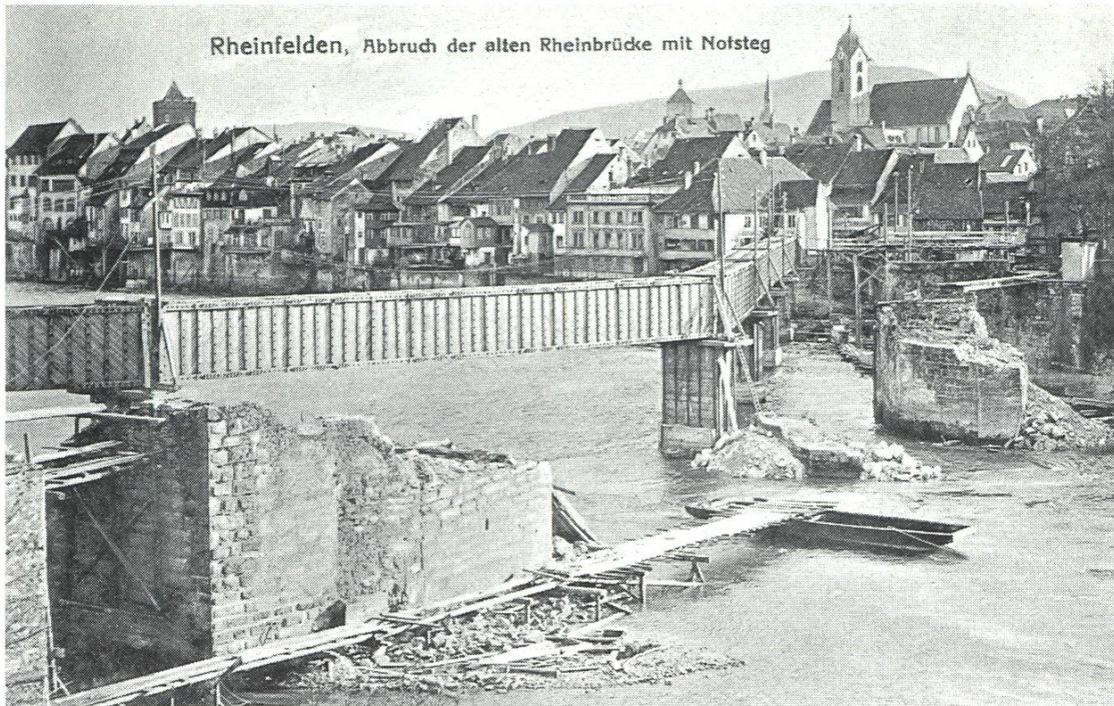
Abb. 18: Abbruch der alten Brücke mit Notsteg.
