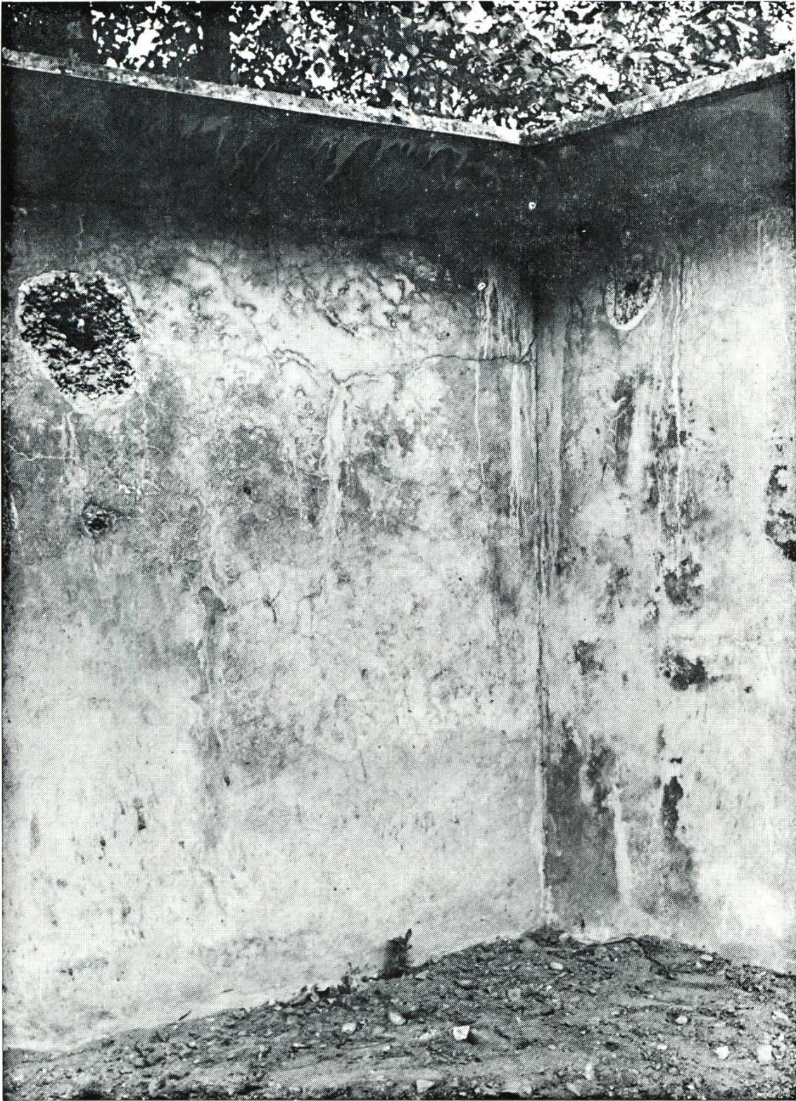
Der Mauerwinkel mit Loch 1 (links) und Trichter 2 (rechts).
