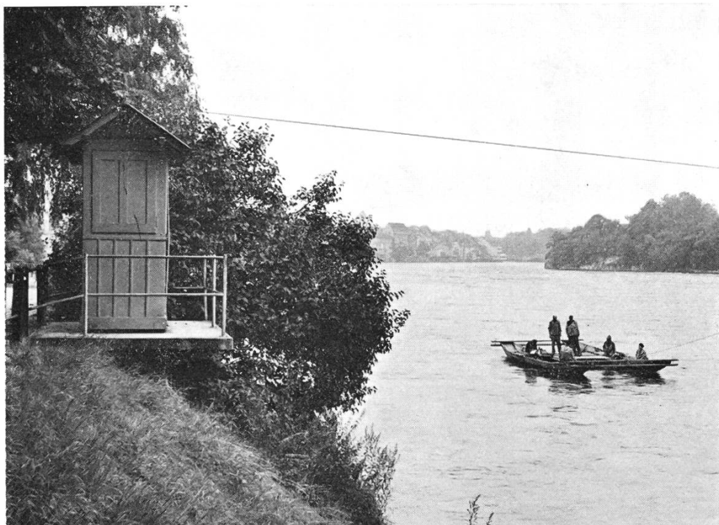
Bild 1. Wassermessstation Rhein - Rheinfelden. Limnigraphenhäuschen am Rheinuferweg, Fährseil, Messfähre mit Mannschaft. Im Hintergrund die Wasserfront der Stadt Rheinfelden.
