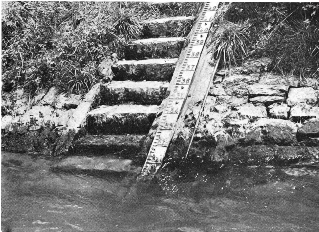
Bild 3. Pegel. (Gusseiserner Böschungspiegel, die Zahlen bedeuten Dezimeter Wasserspiegelhöhe über dem Pegel-Nullpunkt.)
