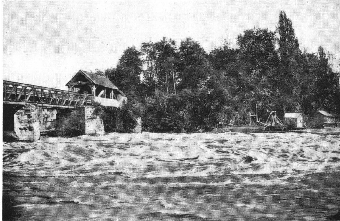
Teile der alten Brücke
