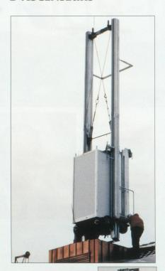
Il y a quelques mois Schindler a présenté à Munich un ascenseur d'un genre radicalement nouveau. Le "SchindlerMobile" est un système autoporteur indépendant du
