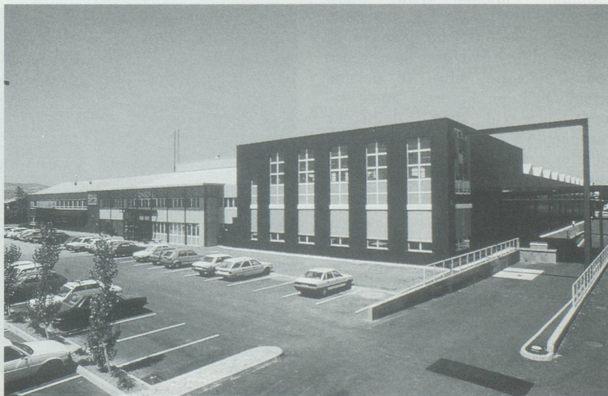
Photo : Les bâtiments de SFS Stadler SA à Valence.
