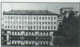
Le Moulin, chef d'œuvre du futur site de Nestlé France à Noisiel.
