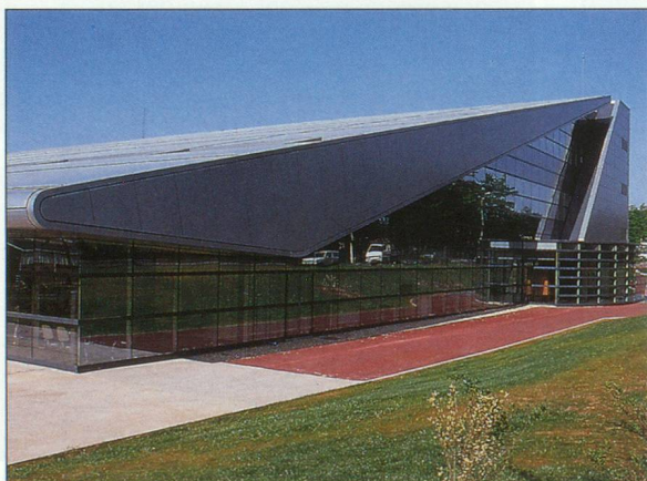
Glaxo : le nouveau bâtiment pour la production des comprimés
