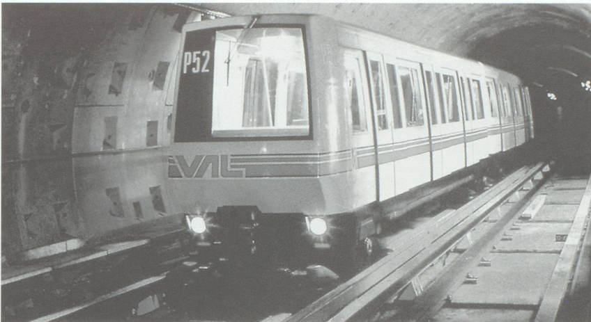
Métro automatique Val en section souterraine. © IAURIF - Médiathèque
