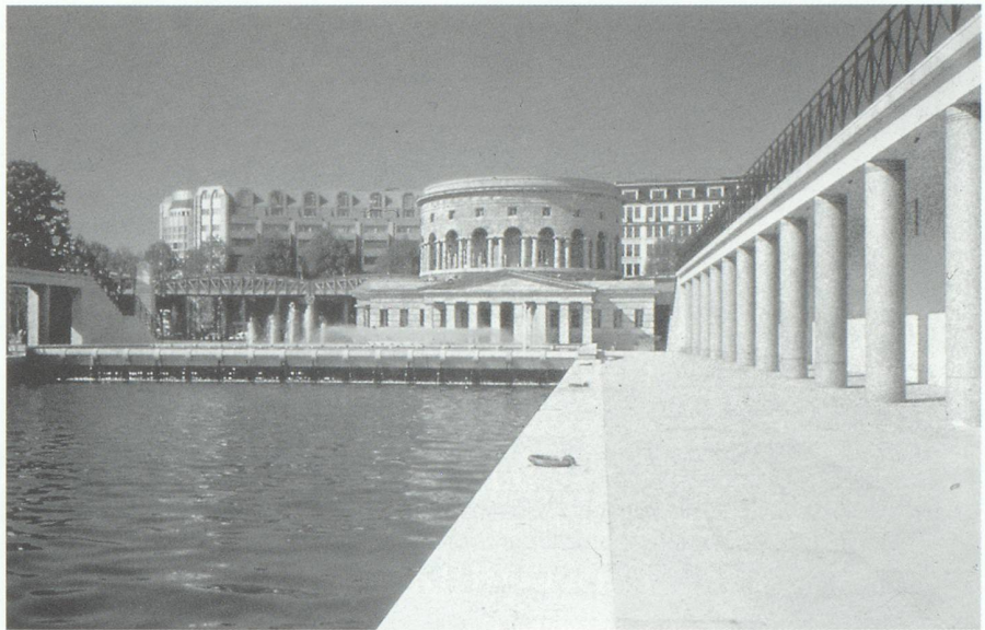
▲ Bassin et Rotonde de la Villette, Paris 19 e arrondissement. © Atelier Parisien d'Urbanisme (APUR).
