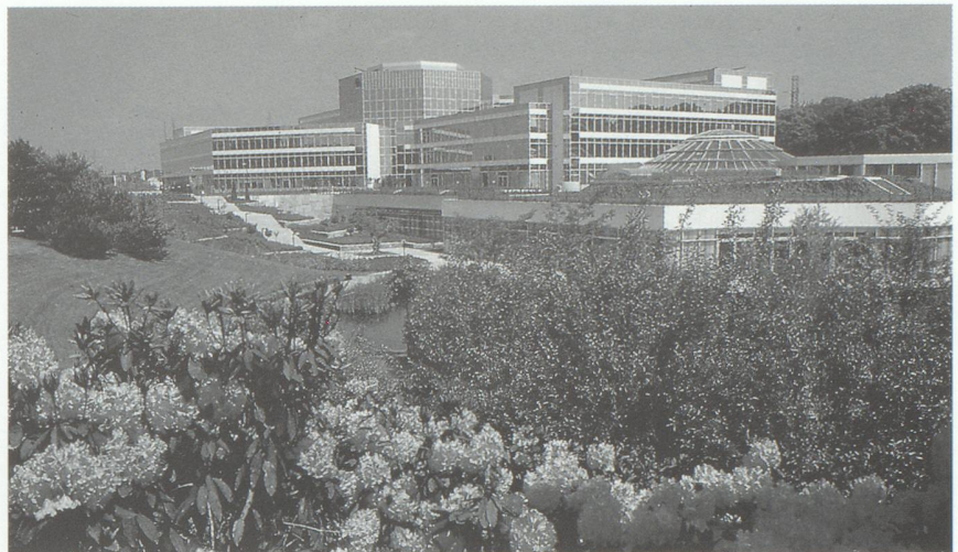
Bureaux à Saint-Quentin-en-Yvelines. ...«Cette nouvelle ville dégage chaque année 4 000 emplois supplémentaires»...
