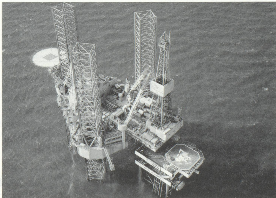
Plate-forme de forage sur HIDRA en Argentine, 1989. Photo : TOTAL-LIESSÉ.
