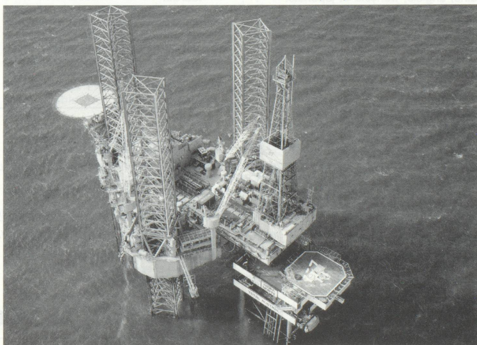
Plate-forme de forage sur HIDRA en Argentine, 1989. Photo : TOTAL-LIESSSE.
