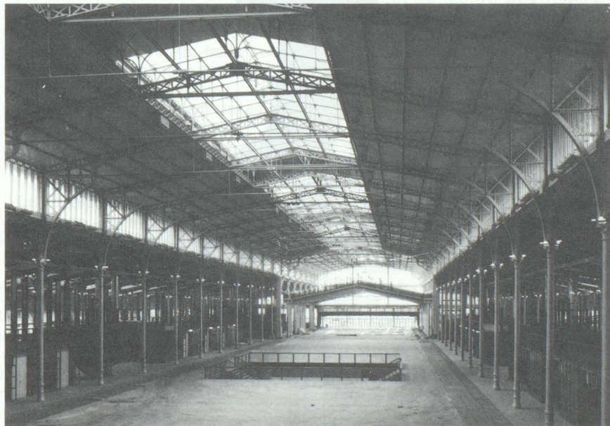
Grande Halle de la Villette à Paris : L'ancien marché aux bestiaux des abattoirs de la Villette est aujourd'hui un hall d'expositions et de manifestations culturelles variées. Des passerelles et des plateaux mobiles peuvent être déplacés tout au long de la nef centrale, sur des rails. Maître d'Ouvrage : Etablissement Public du Parc de la Villette - Architectes : Reichen + Robert (Assistante : H. French) - Scénographe : G.C. François et J.H. Manoury.
