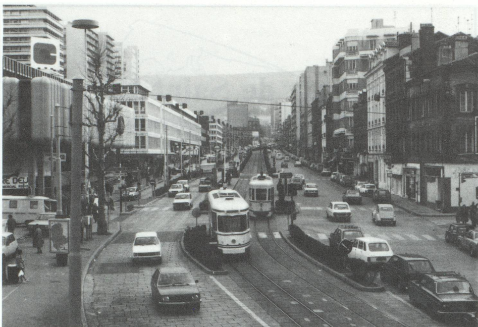
Le tramway à proximité du complexe commercial Centre Deux en 1986.
