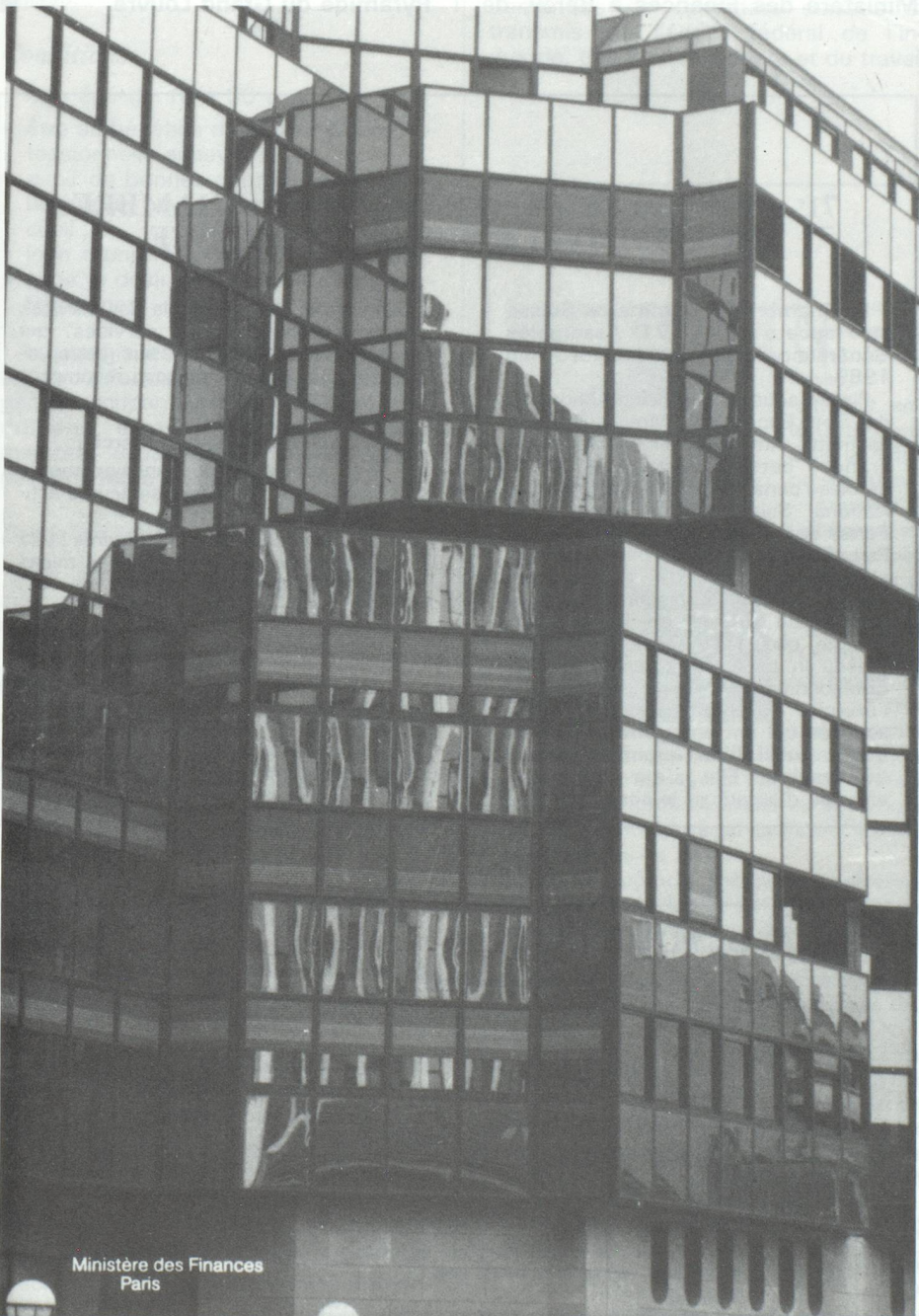
Photo : le Ministère des Finances à Paris équipé de stores Griesser
