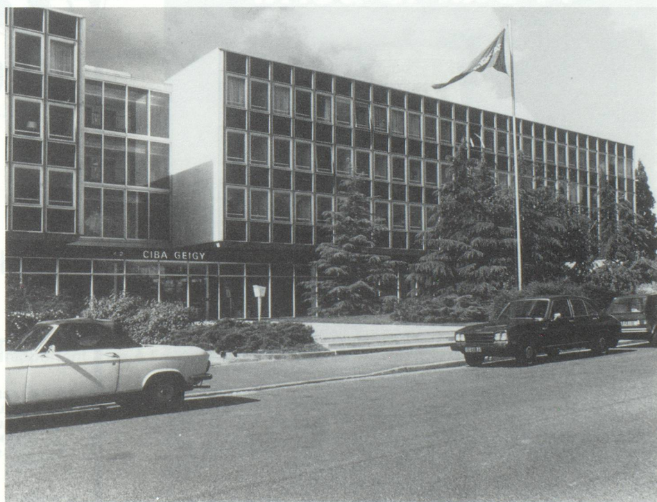
Le Siège de Ciba-Geigy France à Rueil-Malmaison.
