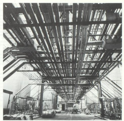
Pont de tuyaus de conduite pour le transport de dissolvants et d'agents chimiques fluides (Photo : Ciba-Geigy).
