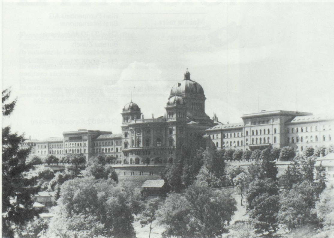
... Le palais fédéral. Édifié en deux phases au milieu du XIX e siècle par Friedrich Studer pour l'aile ouest et Hans Wilhelm Auer pour le bâtiment parlementaire et la partie orientale (copie de la partie occidentale).
