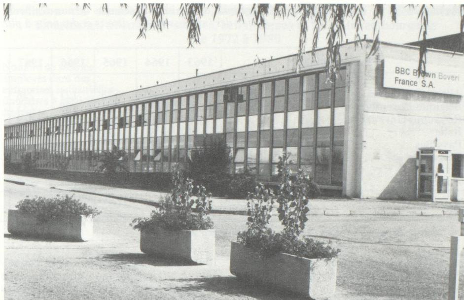
Usine de Décines (Rhône) de la nouvelle Société BBC Brown Boveri France SA, où sont fabriqués des moteurs asynchrones de 0,1 à 15 kw.
