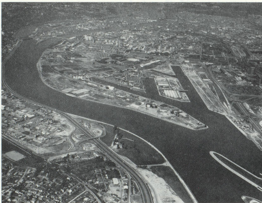
Vue générale du Port Edouard Herriot à Lyon
