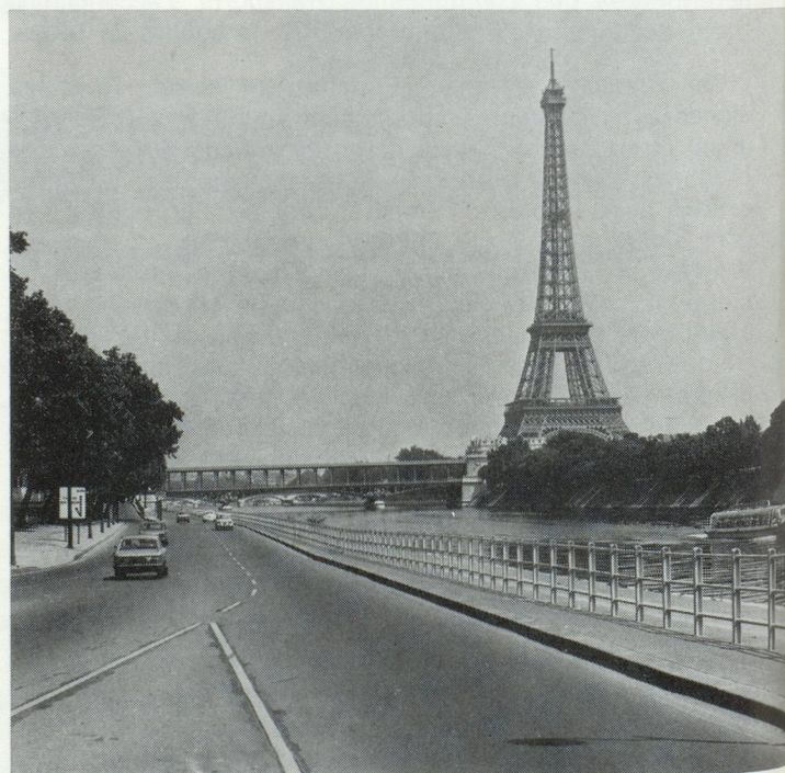
Voie express sur la Rive Droite de la Seine entre le Pont de Grenelle et le Pont de Bir Hakeim
