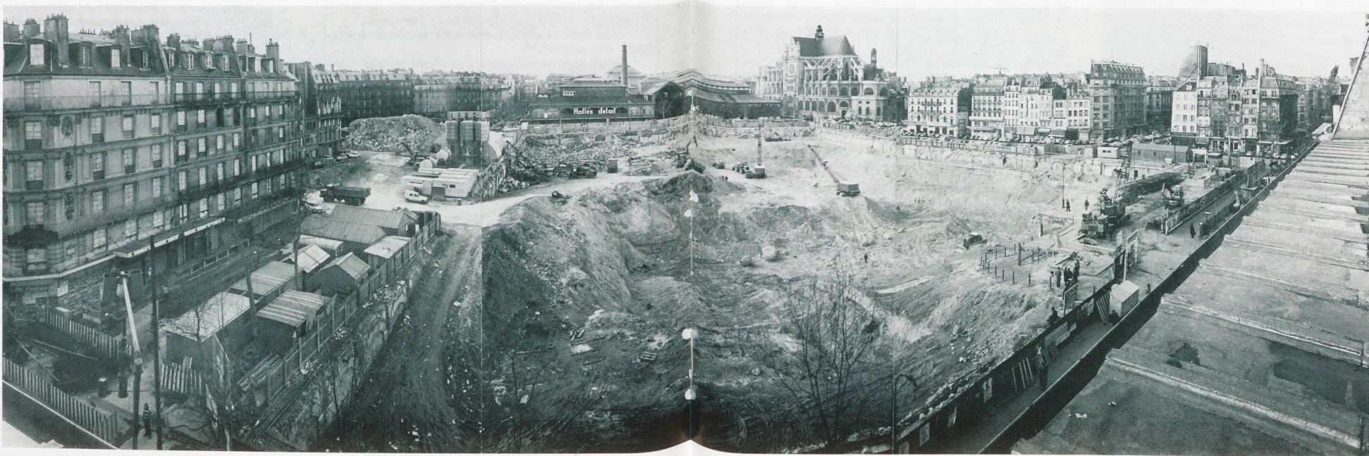
Vue panoramique du chantier des Halles (fouilles RER + Forum)
