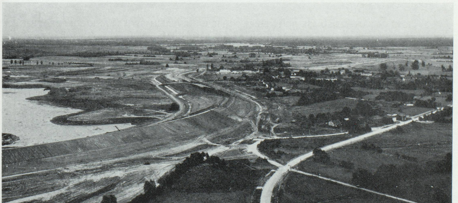
Réservoir « Marne », digue de Giffaumont
