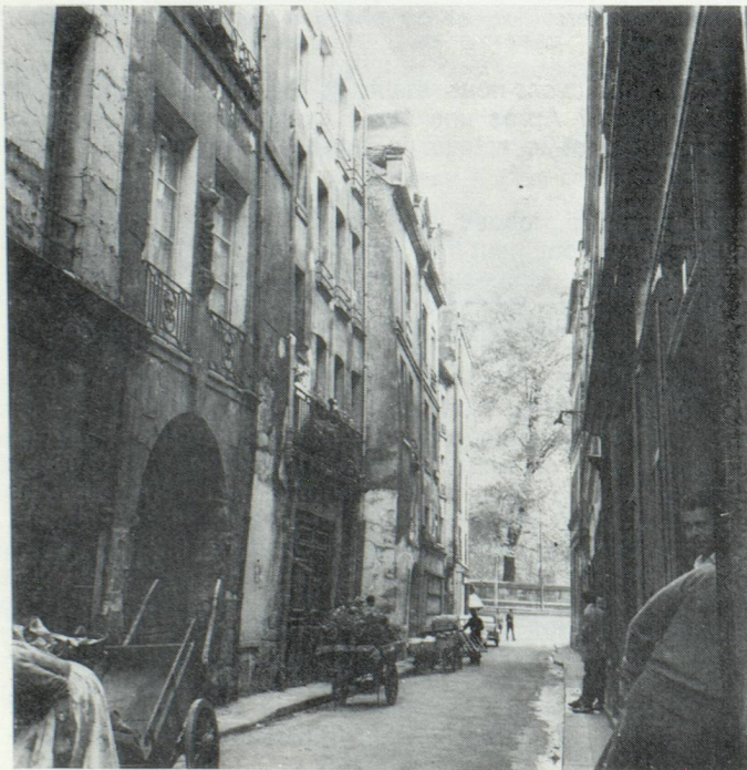
Rue de Bièvre avant restauration
