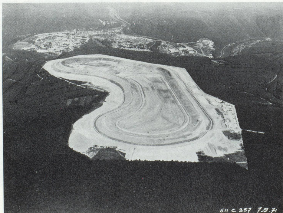
Revin : vue du bassin supérieur au cours des travaux
