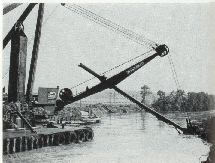
Draguage dans le lit de l'Aar à l'amont de Soleure. Entre Bienne et Flumenthal, l'Aar a une profondeur moyenne d'au moins 5 m et une largeur de 80 à 120 m.
