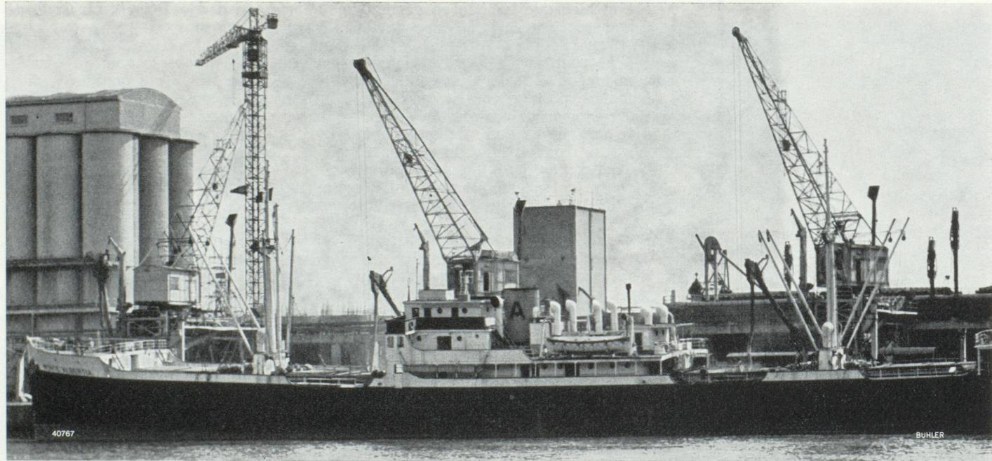
*Dans le port de Rouen : Tous les transporteurs à chaîne du silo de 20 000 t du Port Autonome (à gauche) ont été fabriqués par BUHLER. Trois portiques ayant chacun une ligne SKT/BKT de 150 t/h servent au déchargement et au chargement de bateaux. Un portique de 300 t/h est encore en cours de montage pour le chargement de bateaux. Trois autres dispositifs SKT de 150 t/h chacun sont à disposition pour le déchargement et le chargement de bateaux.*
