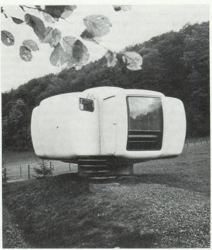
Certes les plastiques se sont déjà imposés pour les toitures translucides en polyènesters armés de fibre de verre ou transparentes en PMM, parfois allié au PVC. Les sols en carrelages de PVC chargés d'amiante, ont remplacé les planchers en bois. Les cloisons, comme les murs-rideaux se font aussi en polyènesters armés, en ABS, en PCV. Parfois deux parois sont alors réunies par du PCV alvéolavie réticulé à l'aide d'un polyuréthane afin d'éviter
