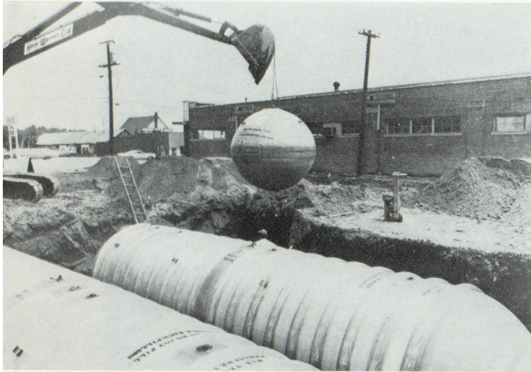
Mise en place d'une citerne sphérique de 5 700 litres en plastique armé, à côté de deux citernes cylindriques de 38 000 litres, lors de la construction d'une nouvelle station d'essence
