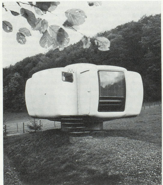
La bulle orientable six coques en plastique armé de Dubigeon-Normandie (architecte : Jean Manneval)
