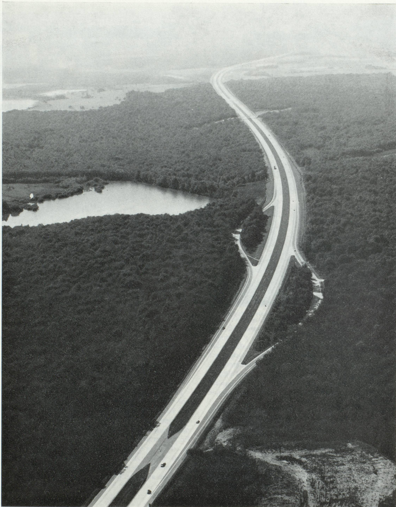
Bois de la Roche. Autoroute du Sud entre Nemours et Auxerre (Photo du Service des relations extérieures de l'Équipement de la Région Parisienne)
