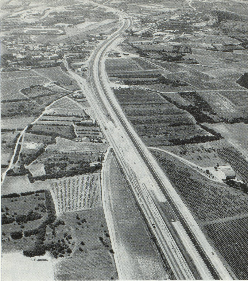
Autoroute A 7. Section déviation Sud d'Orange à Sainte-Anne-de-Vedene. Vue générale du chantier. Poste d'enrobage 150 T/h.
