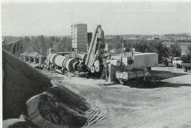
Autoroute A 7. Section déviation Sud d'Orange à Sainte-Anne-de-Vedene. Vue générale du chantier. Poste d'enrobage 150 T/h.
