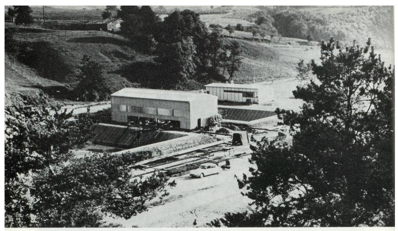
Nouveau stockage souterrain à Tersanne (Drôme). Deux cavités de 100 000 m³ chacune sont actuellement creusées par lessivage à l'eau douce d'un gisement de sel, à 1 400 mètres sous terre, en vue d'emmagasiner, sous 200 bars de pression, le gaz destiné à couvrir les émissions d'extrême pointe de la région lyonnaise. C'est le premier stockage de ce type aménagé par le Gaz de France.
