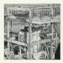
La centrale nucléaire St. Laurent de l'Electricité de France, d'une puissance de  $480\,000\,\mathrm{kW}$ , est équipée de générateurs de vapeur, d'un système de réglage et de soufflantes de CO2 Sulzer.
