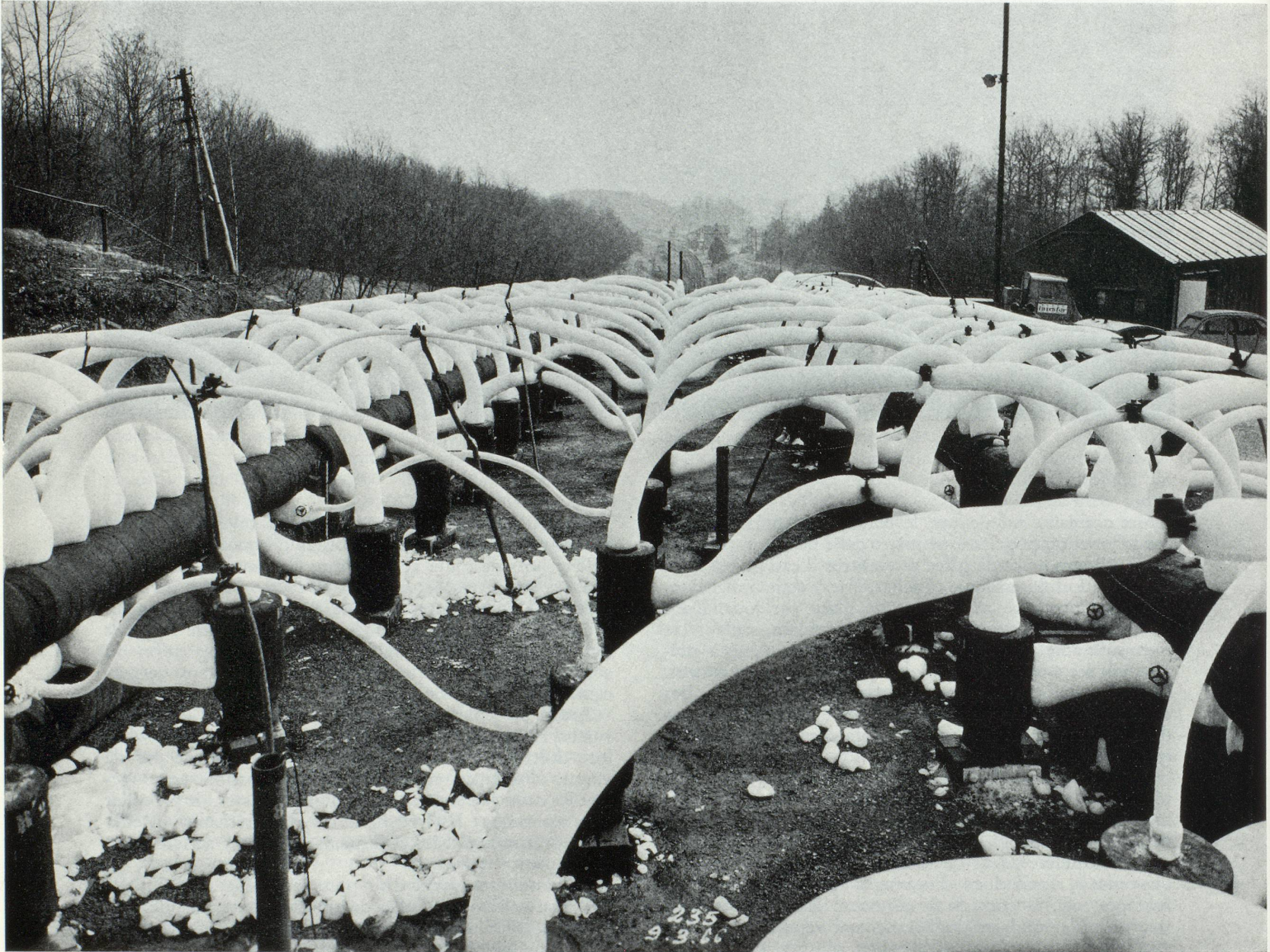
Congélation de la voûte du tunnel de Genevreuille — détail de la distribution du froid. (Photo Escher Wyss)
