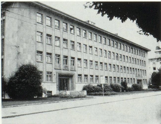
Siège de la Chambre suisse de l'horlogerie, La Chaux-de-Fonds.
