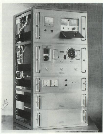
Fig. 1. — Horloge Atomique. (Photo J. Schæpflin).
