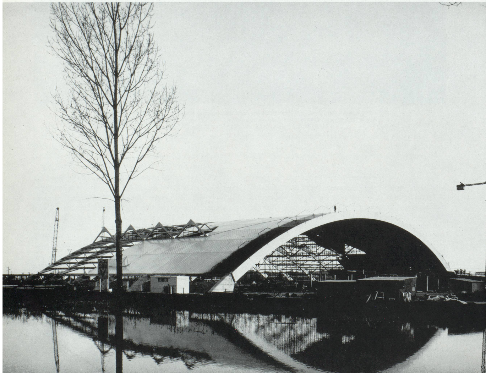
Hall d'exposition des Foires de Tours. Fabrication et montage en quatre mois. Photo Candelier - ÉZY (Eure).
