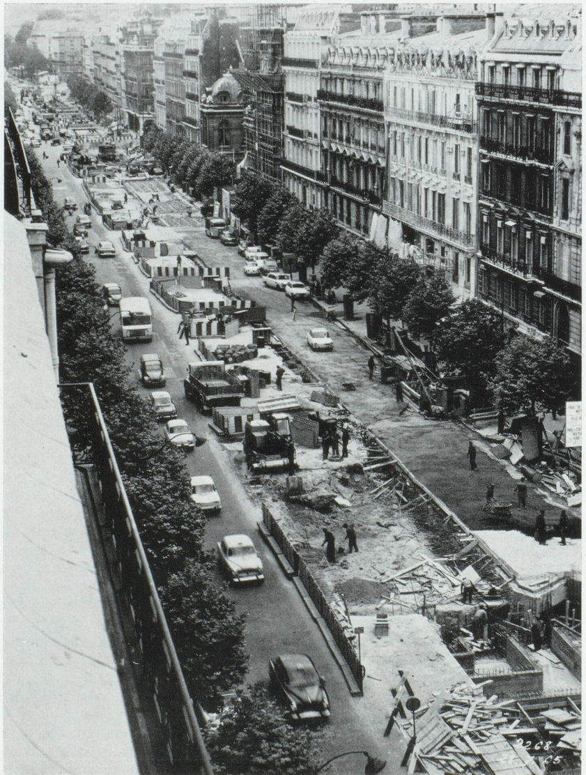
Parking Haussmann Phase initiale des travaux.
