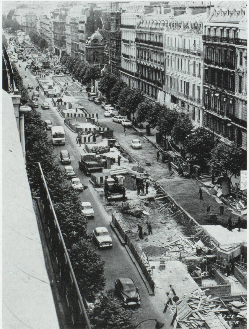
Parking Haussmann Phase initiale des travaux.
