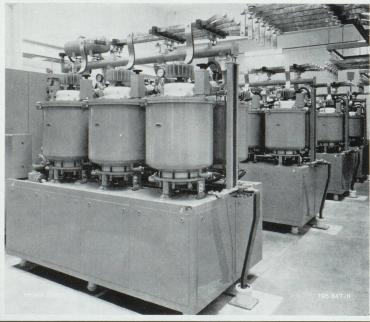
La Société Brown Boveri a livré à l'organisation européenne pour la recherche nucléaire (CERN) à Genève, l'installation électrique complète pour l'alimentation de l'électro-aimant du synchrotron à protons en régime pulsatoire, à partir du réseau à 18 kV de la ville de Genève.
