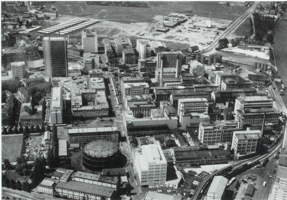
Vue aérienne des Usines Sandoz à Bâle
