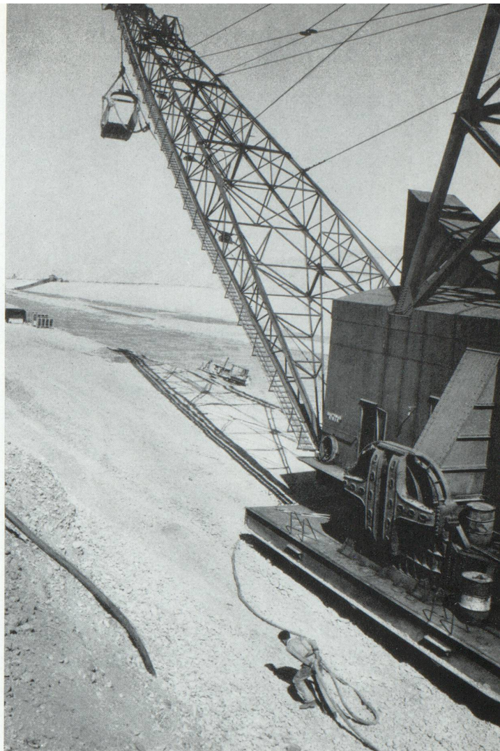
L'aménagement progressif du Rhin pour la navigation et la production électrique suscite la construction de vastes usines.
