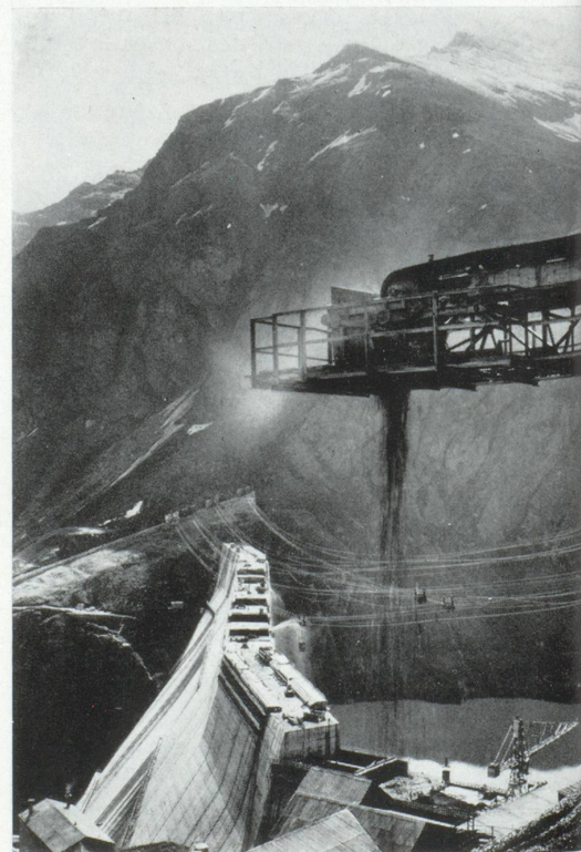
Ci-dessous et à droite la construction du barrage de la Grande Dixence.
