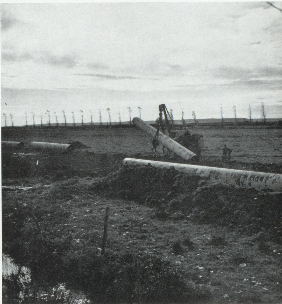
Pose d'un pipe-line européen.
