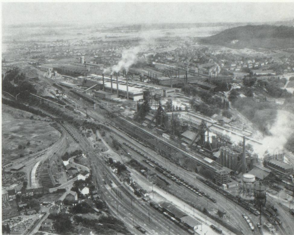
Hauts fourneaux et usines sidérurgiques de la vallée de la Fensch.
