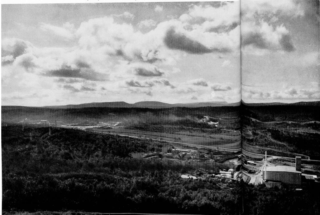
Le Centre d'énergie nucléaire de Cadarache; à gauche au fond le chantier de « Rhapsodie »; au premier plan à droite l'ensemble « Pégase » (d'après CEA).
