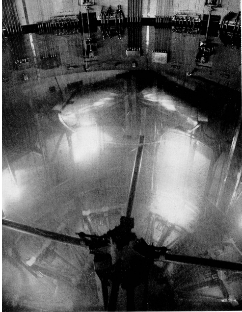
Pile piscine « Pégase » à Cadarache (C.E.A.).
