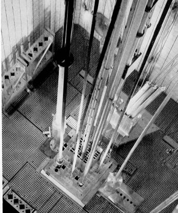
Cœur avec élément combustible (uranium enrichi à 90 %) de la pile Siloé (C.E.A.).
