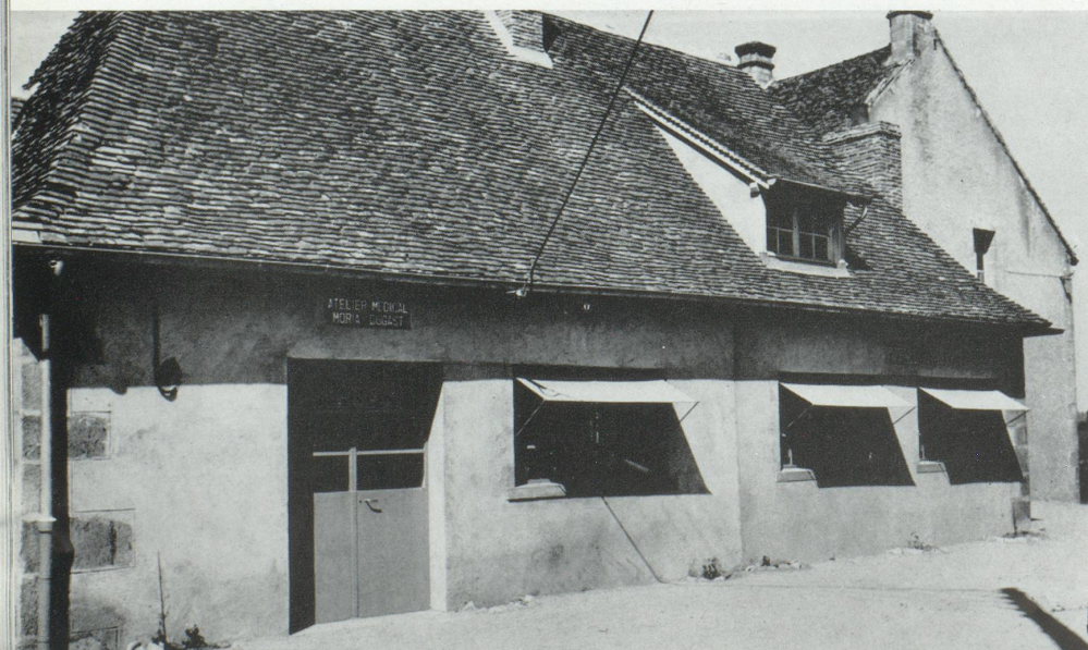
Vue extérieure de l'atelier de Bourbon l'Archambault.
