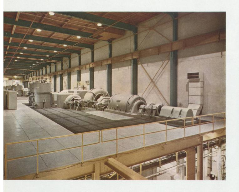
Ci-dessus : salle des machines de la centrale à turbines à gaz de Port Mann de la British Columbia Electric Company, Vancouver (Canada). Cette centrale comprenant quatre groupes de 25 000 kW est actuellement une des plus grandes centrales à turbines à gaz du monde. Les turbogroupes à gaz étaient livrés par la maison Brown, Boveri à Baden.
