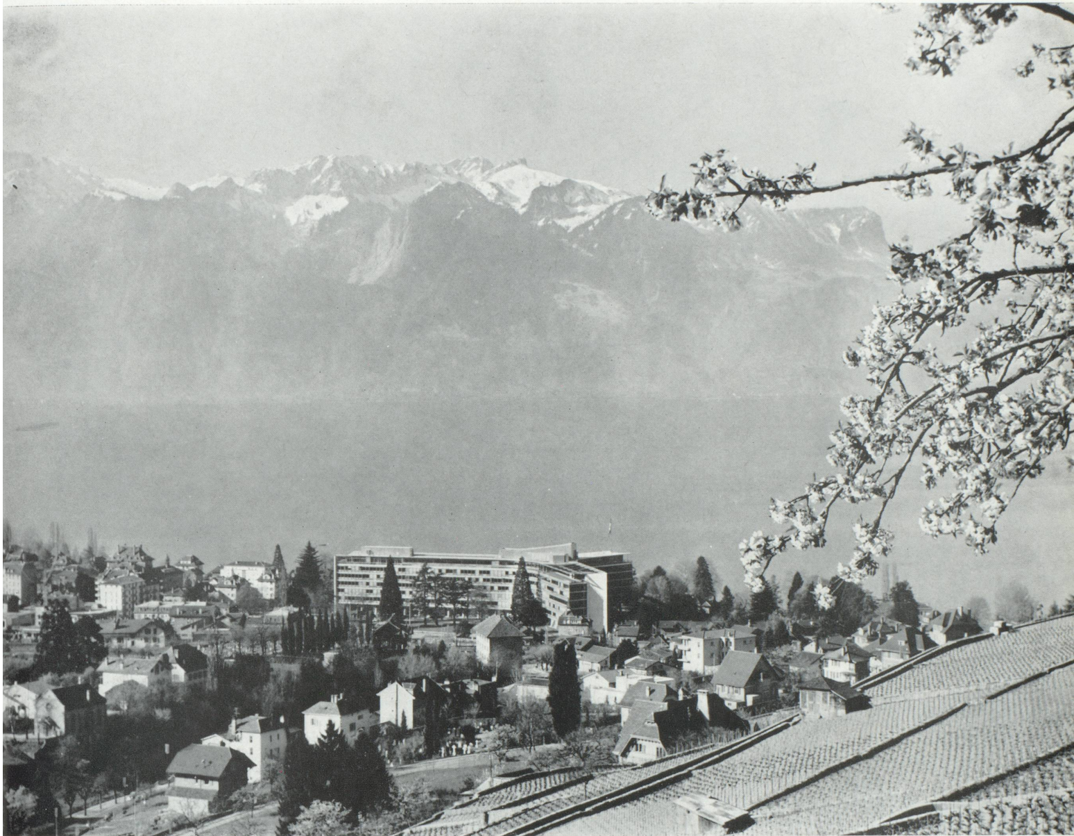
Centre administratif de Nestlé Alimentana à Vevey.
